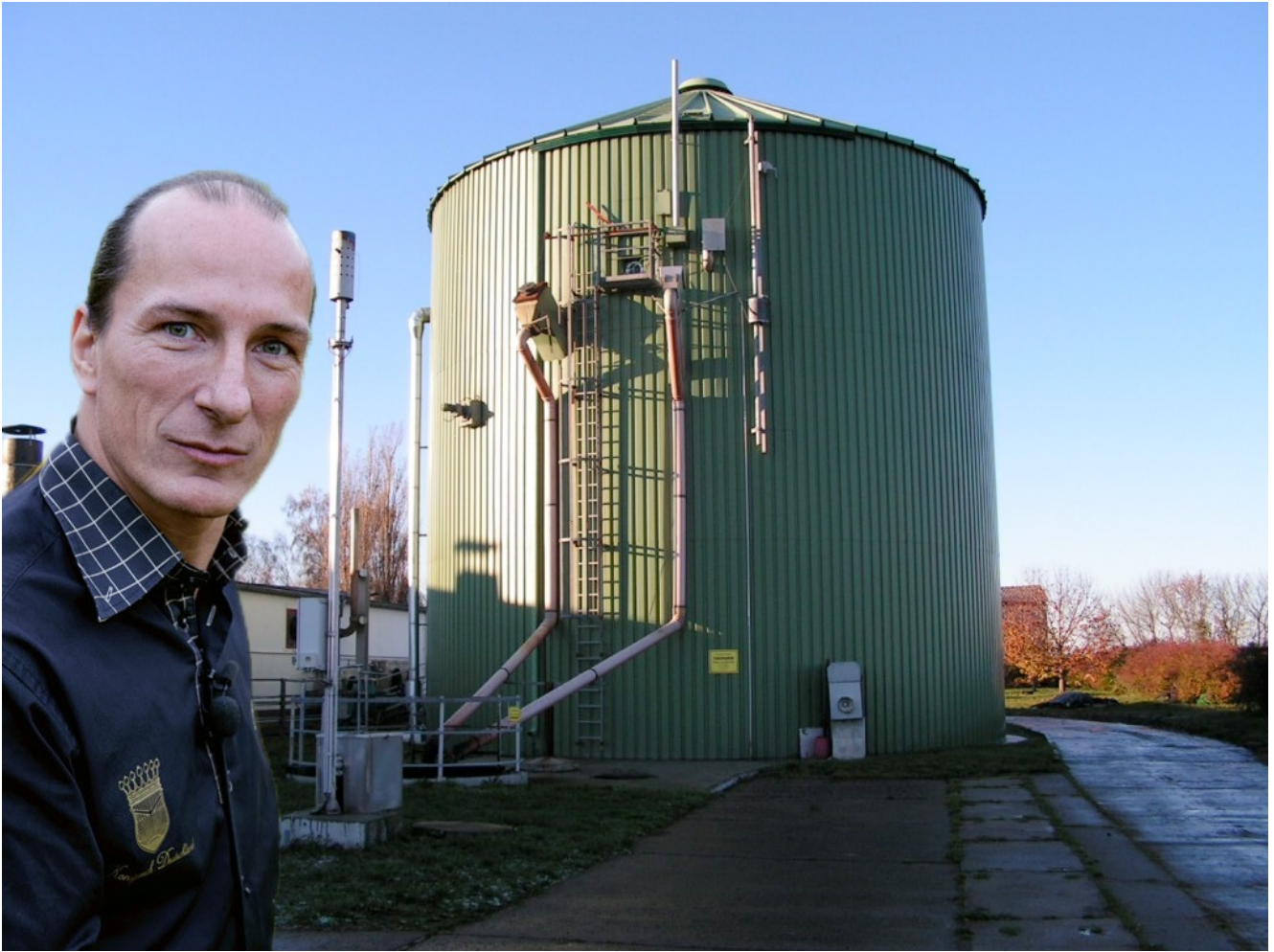
Peter Fitzek stolz vor seiner Biogasanlage
